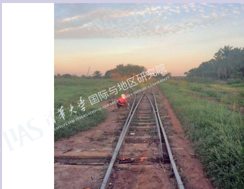
图2 中线铁路，德属坦噶尼喀时修建 作者拍摄
