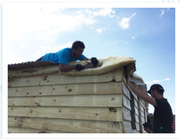
图9 完成屋顶的搭建 作者拍摄
