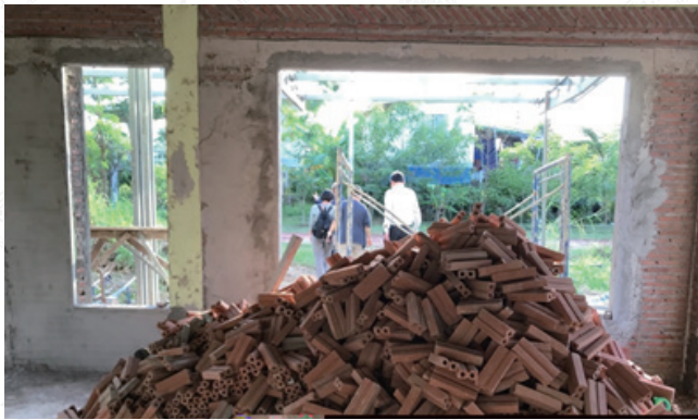
图 2 正在建设的工人新村房屋
