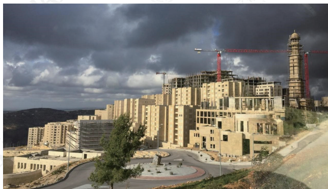
图 4 建设中的拉瓦比新城
